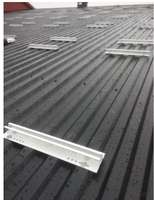
Bilder fra installasjon av solcellebraketter på bølgeblekk
